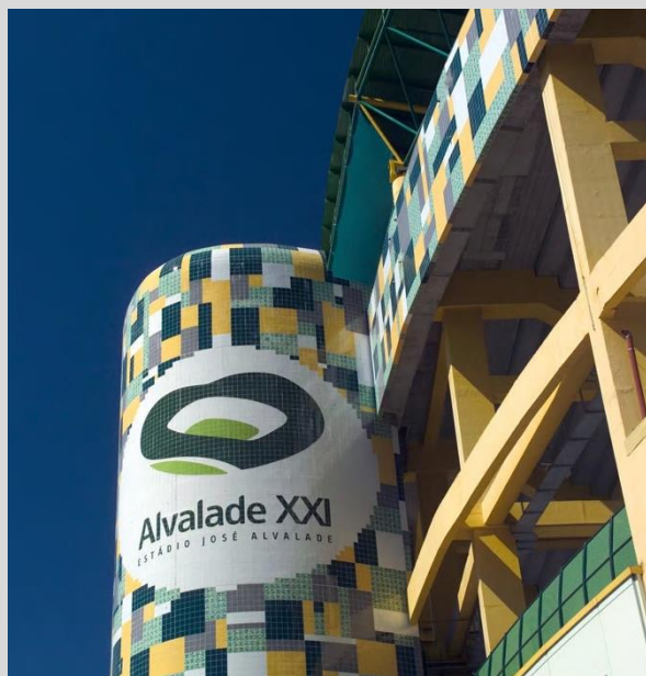
ESTÁDIO DE ALVALADE XXI LISBON, PORTUGAL
