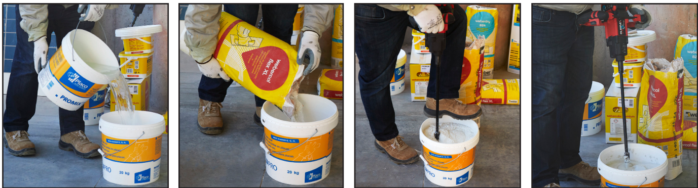
Fig. 17/18/19/20 Misture o conteúdo do saco de cimento cola com água limpa, utilizando um misturador elétrico de baixa rotação, até obter uma mistura homogênea e sem grumos. Deixe repousar dois minutos e misture novamente.
