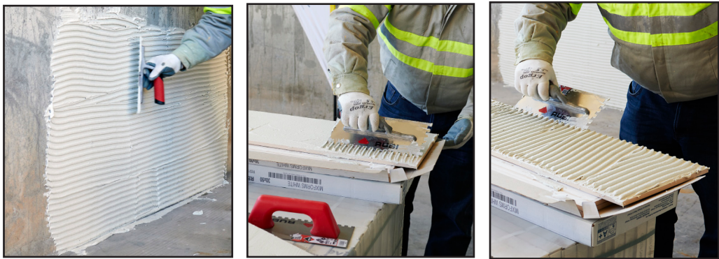
Fig. 21/22/23 Espalhe o cimento cola em pequenos panos (máximo, 1m²) sobre o suporte, em barramento fino e apertado, para hidrofugação do mesmo, com a ajuda de uma talocha dentada adequada.
