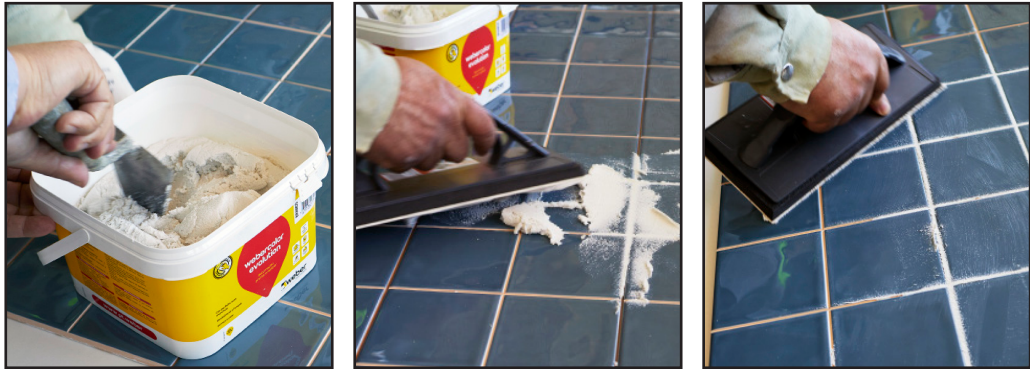
Fig.36/37/38 A argamassa deve ser aplicada com uma talocha de borracha, na diagonal relativamente à direção das juntas. Garanta a uniformidade da aplicação das argamassas nas juntas, de forma a aumentar a durabilidade das mesmas.
