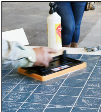
Fig.36/37/38 A argamassa deve ser aplicada com uma talocha de borracha, na diagonal relativamente à direção das juntas. Garanta a uniformidade da aplicação das argamassas nas juntas, de forma a aumentar a durabilidade das mesmas.
