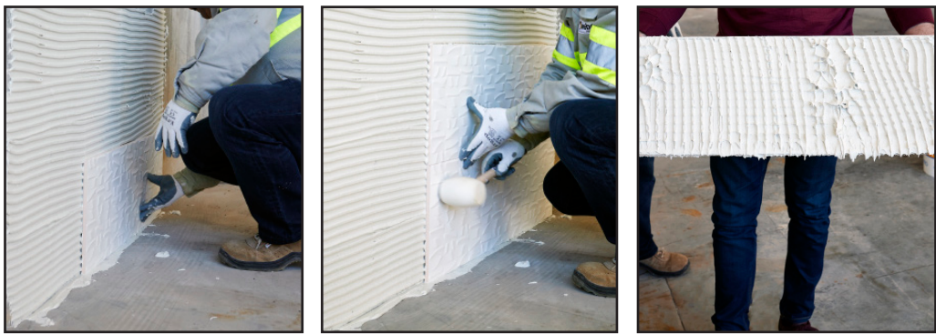
Fig.24 De seguida, aperte a peça contra o suporte de forma a esmagar os cordões de cimento cola, garantindo que a totalidade da área fica preenchida.
