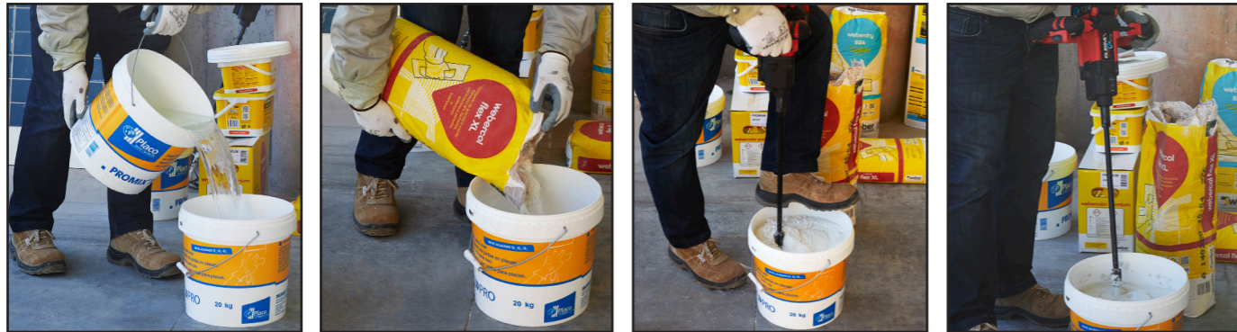
Fig. 17/18/19/20 Mélangez le contenu du sac du ciment-colle avec de l'eau propre à l'aide d'un mélangeur électrique à faible vitesse jusqu'à ce que le mélange soit homogène et sans grumeaux. Laissez reposer pendant deux minutes et mélangez à nouveau.
