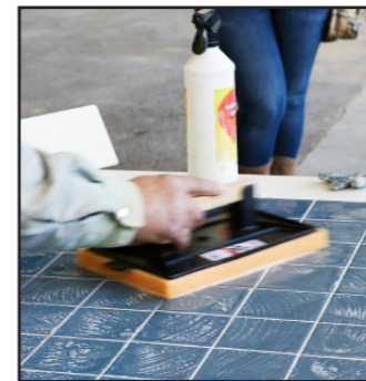
Fig.39 Lors du nettoyage final (à l'aide d'une éponge ou d'un chiffon humide), n'utilisez pas trop d'eau pour ne pas tacher les mortiers colorés et nettoyez soigneusement les carreaux de céramique qui contiennent des résidus de mortier.
