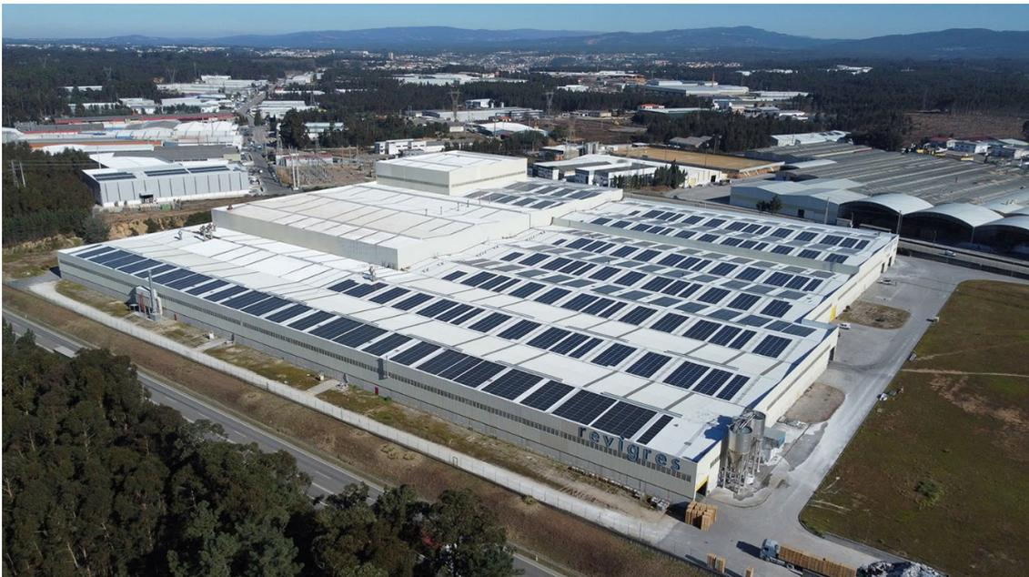
Zu diesem Zweck hat das Unternehmen ein Photovoltaik-Kraftwerk für den Eigenverbrauch errichtet, das 19 % des Gesamtenergieverbrauchs der Produktionsanlagen deckt und den CO<sub>2</sub>-Ausstoß um 1.826 Tonnen pro Jahr reduziert.
