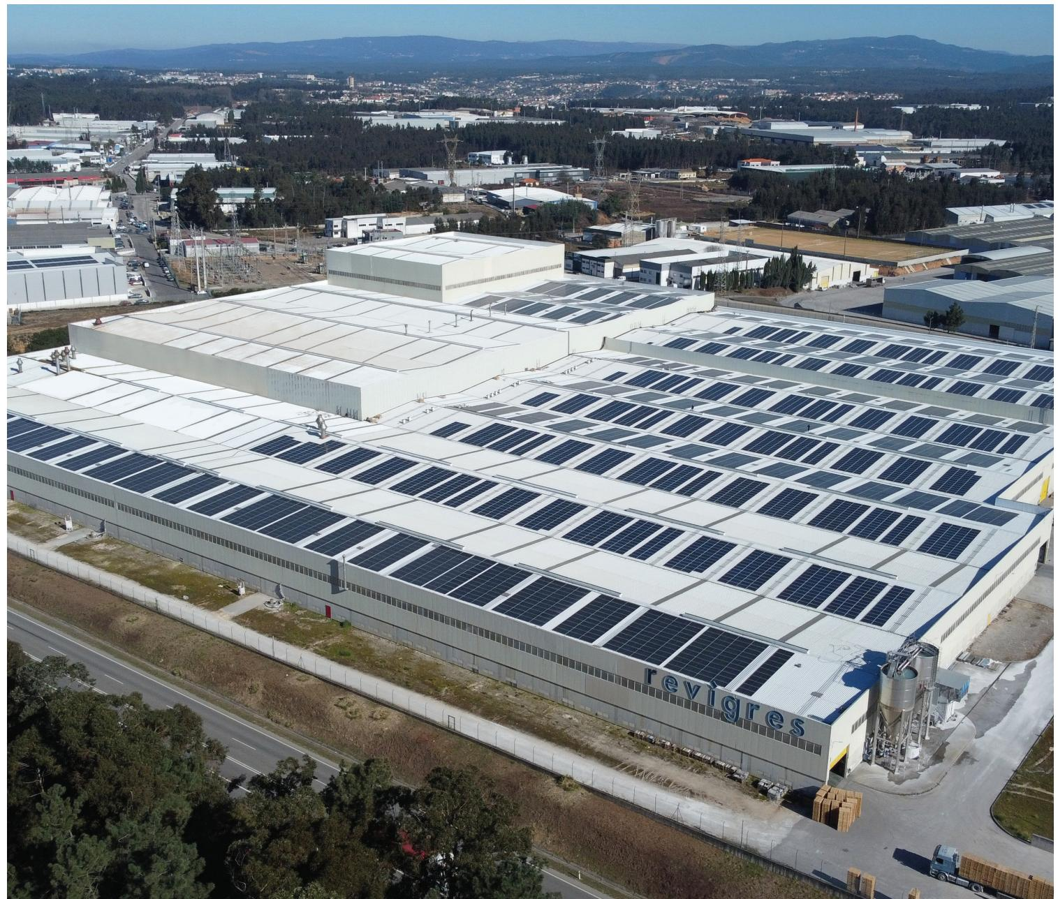
Installation d'une Centrale Photovoltaïque pour l'Autoconsommation, inaugurée par le Ministre de l'Environnement et de l'Action Climatique - Duarte Cordeiro, en avril 2023. 7328 panneaux photovoltaïques qui produisent 4 GWh/an d'énergie propre - environ 20% de la consommation d'énergie électrique des unités de fabrication - en évitant l'émission de 1826 tonnes de CO2 par an.
