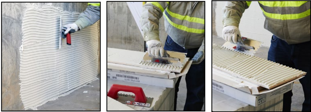
Abb. 21/22/23 Spachteln Sie den Klebemörtel in einer dünnen, kompakten Schicht auf kleine Abschnitte (maximal 1 m2) des Untergrunds, sodass eine gute Abdichtung erzielt wird. Verwenden Sie dazu eine geeignete Zahnkelle.
