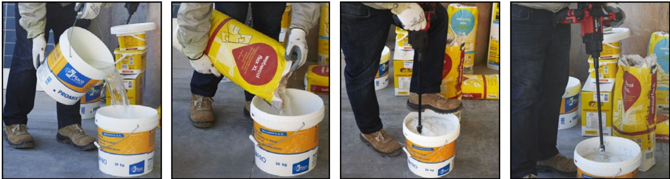
Fig. 17/18/19 Mezclar el contenido del saco de cemento cola con agua limpia, utilizando un mezclador eléctrico de baja rotación, hasta obtener una mezcla homogénea y sin grumos. Dejar reposar dos minutos y mezclar de nuevo.
