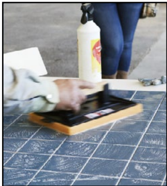
Fig.36/37/38 Aplicar el mortero con una llana de goma, en diagonal con respecto a la dirección de las juntas. Es necesario asegurarse de que los morteros se aplican uniformemente en las juntas para aumentar su durabilidad.
