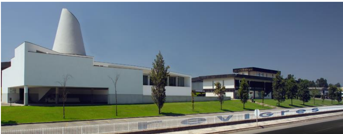
Hauptfassade des Revigrés-Firmensitzgebäudes, in Barrô
