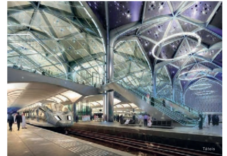
Estação de Metro de Jeddah _ Arábia Saudita Jeddah Underground Station _ Saudi Arabia
